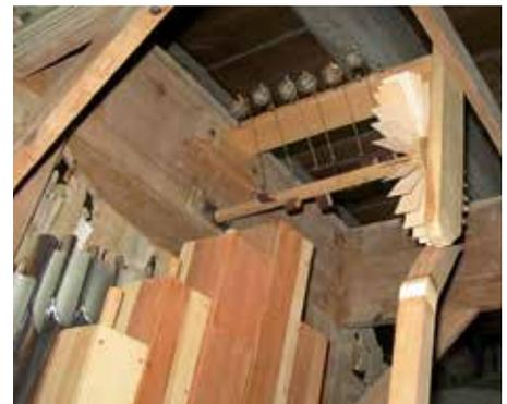
Neuanfertigung und Rekonstruktionen: Das Windrad wurde nach Vorlagen von Wagner neu angefertigt. Die Lagerleiste für die Glocken wurde der Situation vor Ort angepasst und mit sechs Krallenglocken bestückt. Der Stern wurde für die Platzverhältnisse im Orgelprospekt mit acht schlichten Spitzen rekonstruiert. Eine lange Eisenachse und eine Holzwellen mit sechs Nocken führt die Verbindung zum Windrad.
