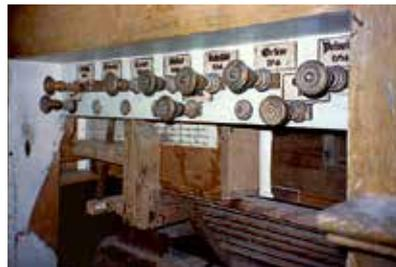
*Spieltisch vor der Restaurierung: Manual- und Pedalklavatur zeigten erhebliche Gebrauchsspuren und waren stark verschmutzt. Die Klaviaturwangen waren vom Wurm befallen, stellenweise lösten sich die Tastenbeläge. Für die abgesägten Manubrien (Knäufel) waren keine Registerschilder vorhanden.*
